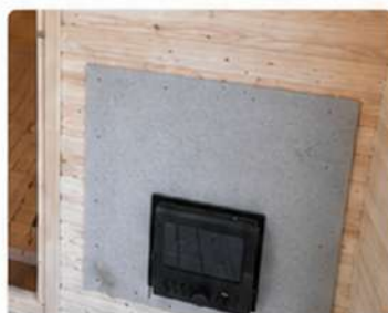
Вынос топки в смежное помещение
